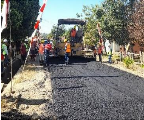
Gambar 3.3 Pembangunan Infrastruktur Jalan
